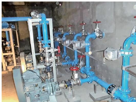
「ナイロン11」コーティング鋼管はさまざまな場所で使用されている（浄水場ポンプ室回り配管での使用例）
