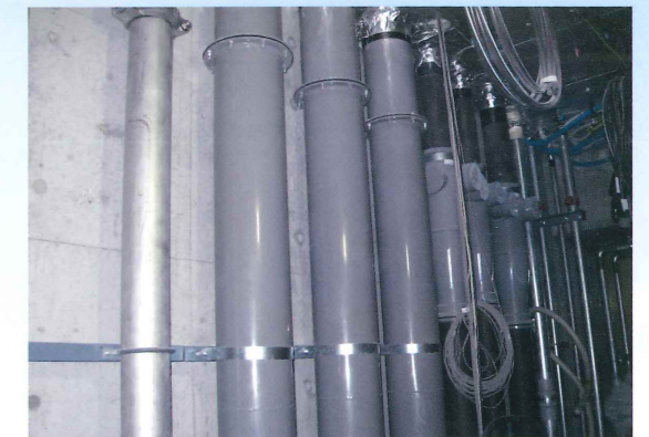
臭突管施工例
