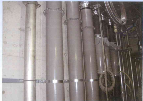
臭突管施工例
