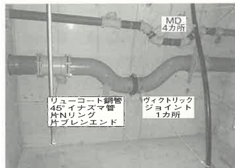
写真5 リューコート鋼管 施工例3
