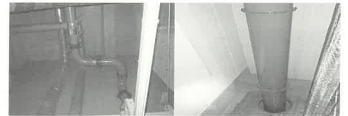
リュウコート鋼管 リュウコートLight 写真2 各種コーティング鋼管
